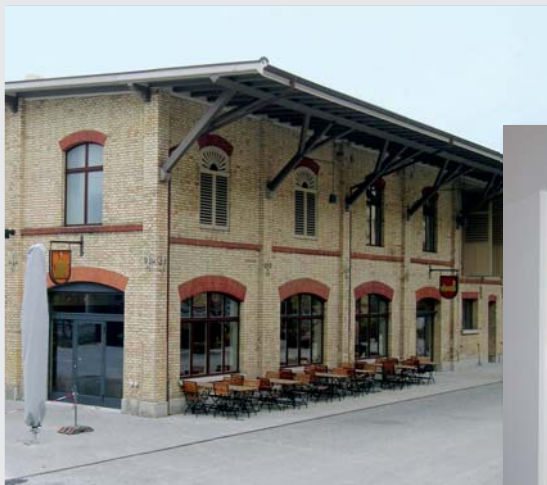
► Hürlimann-Areal, altes Backsteingebäude, neuer Innenausbau mit Brandschutztüren
