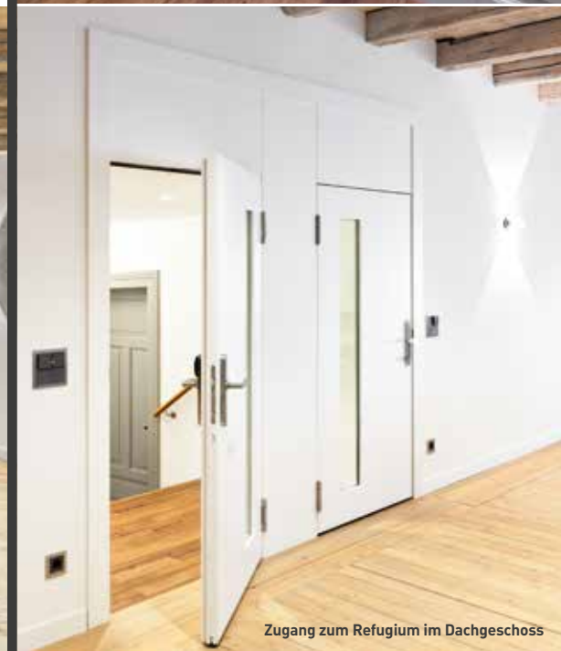
Brandabschnitt zw. Treppenhaus und Büroräumlichkeiten
