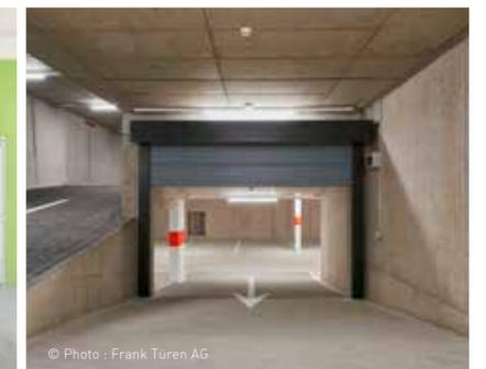
**Garage sécurisé.** Les rideaux coupe-feu sont actionnés par le système de détection d'incendie.
