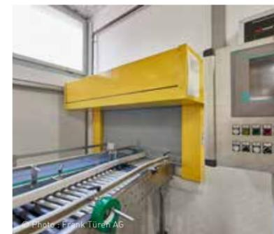
**Sécurité sur mesure.** La réalisation sur mesure des rideaux coupe-feu permet de les intégrer parfaitement aux flux opérationnels de l'entreprise.
