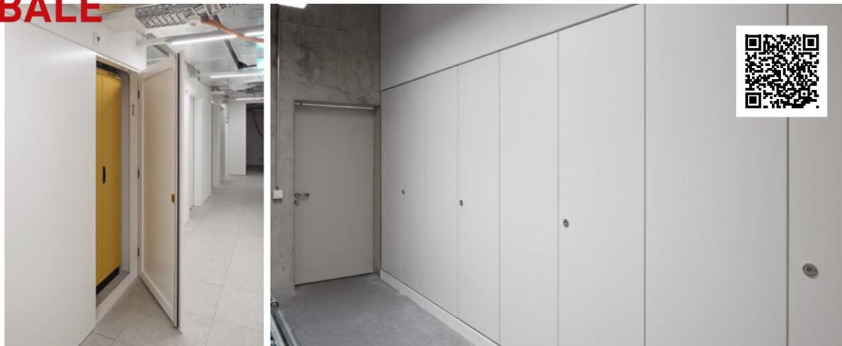
▲ Cloison pour gaines techniques EI30 RF1, façade de porte à 2 vantaux et parement supérieur intégrant une cloison souple avec passages de câbles, Biozentrum Bâle, mise en œuvre par la menuiserie Schneider AG, cabinet d'architecture Ilg Santer Architekten
