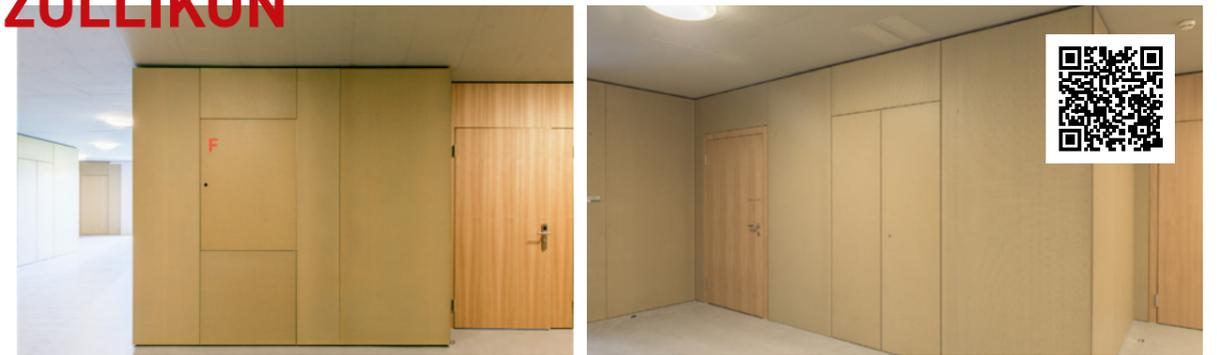
▲ Cloison pour gaines techniques EI30 RF1, façade de porte à 2 vantaux réalisée en Cemcolor. CMS Zollikon, mise en œuvre par von Büren + Sommer AG, cabinet d'architecture Ballmoos Krucker Architekten AG
