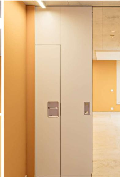
Autre exécution en option : la **porte pliante coulissante avec protection incendie EI30**. Grâce à son mécanisme de pliage innovant, elle ne prend que peu de place et peut soit rester visible, soit être placée dans une niche du mur.
