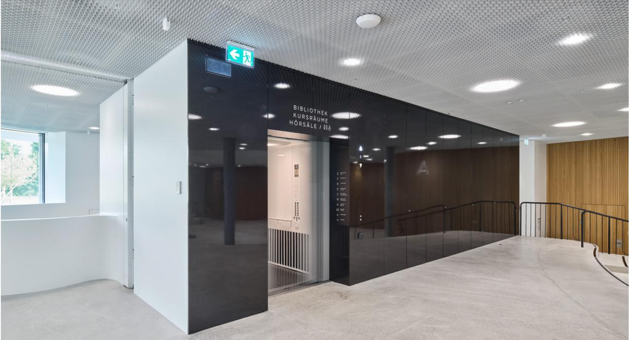
**Schachtfronten sind ein wesentliches Element in der Gebäudearchitektur, wenn es um die sichere Führung und den Schutz von Installationsschächten geht.** Sie dienen dazu, Leitungen, Kabel oder Lüftungssysteme optisch ansprechend zu verkleiden und gleichzeitig den hohen Anforderungen an Brandschutz und Sicherheit gerecht zu werden.
