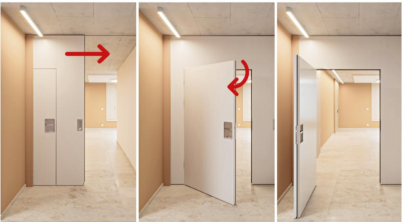
**Die integrierte Servicetüre übernimmt eine doppelte Funktion:** Sie ermöglicht den Personenfluss im Fluchtfall und stellt gleichzeitig den Interventionsweg für Rettungskräfte sicher. Damit erfüllt die Anlage gleich zwei sicherheitsrelevante Aufgaben in einem System.
